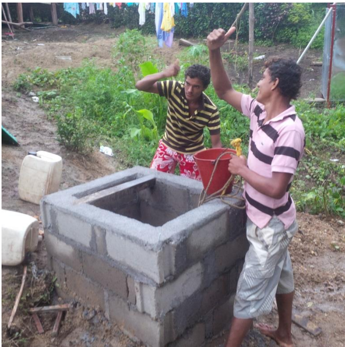
Murs en blocs du réservoir terminés
