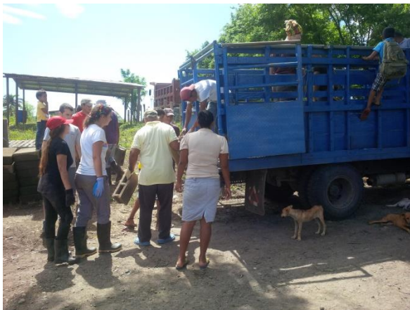
Déchargement des blocs de ciment du camion
