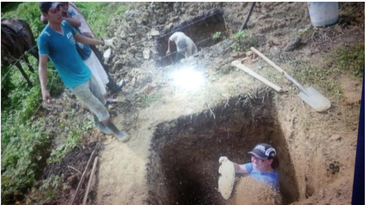
La construction de sanitaires en 2015
