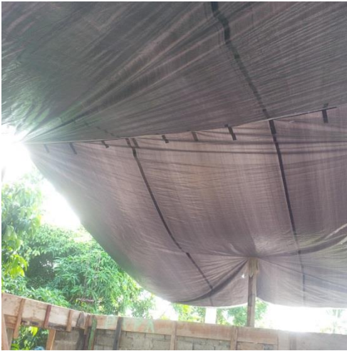
Toit de toile provisoire
