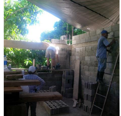
Salle de classe, mur de droite
