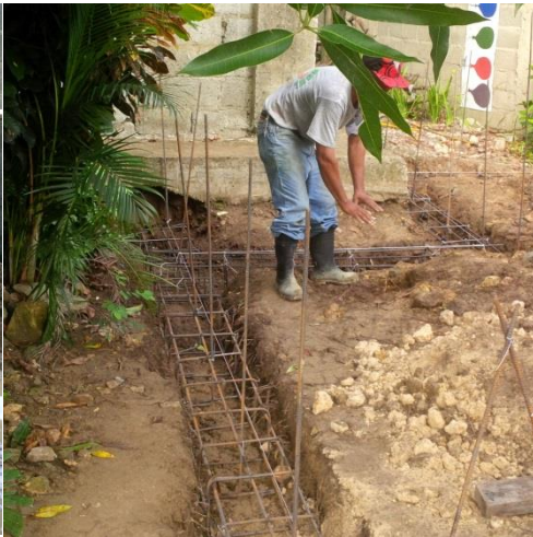
Tranchées et armatures pour les fondations de l'entrepôt
