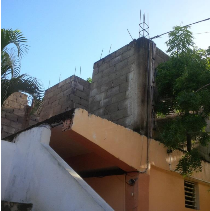
Chantier 1 : c'est là que nous construirons le petit rangement
