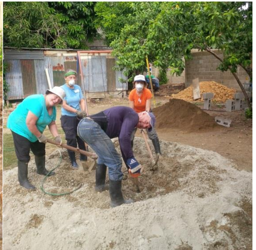
Grosse "batch" de ciment pour les fondations de l'entrepôt Nicole, Diane, Josette et Pierre
