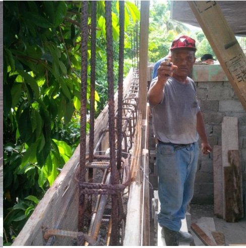
Roberto (chef maçon) et les formes en bois avec les armatures
