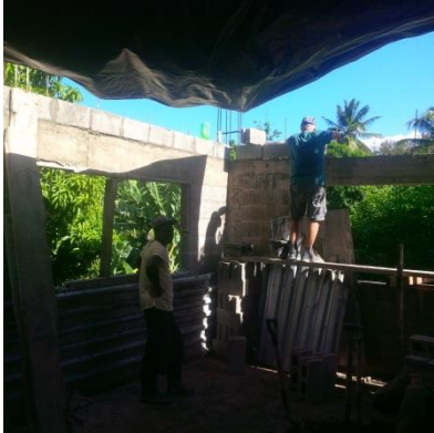
Salle de classe, mur de gauche
