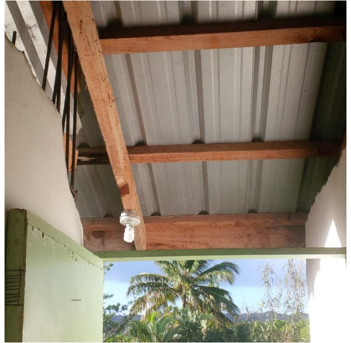
Chantier 1 : le type de toit à placer
