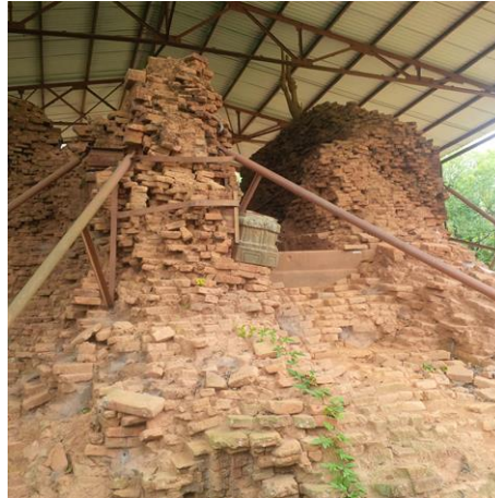
Temple en cours de restauration (Groupe F)
