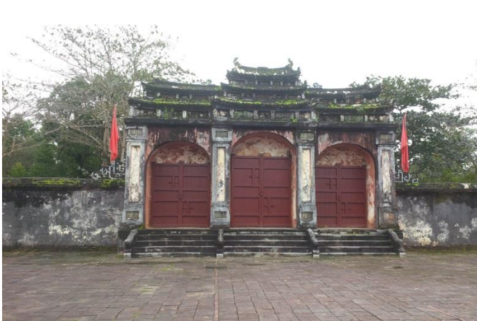
Le portique d'entrée à trois portes
