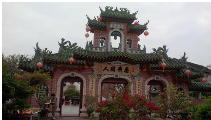
Premier portail d'entrée
